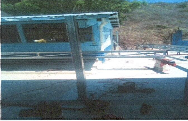
Foto1: Mejoramiento de columnas con estructura metálica.
