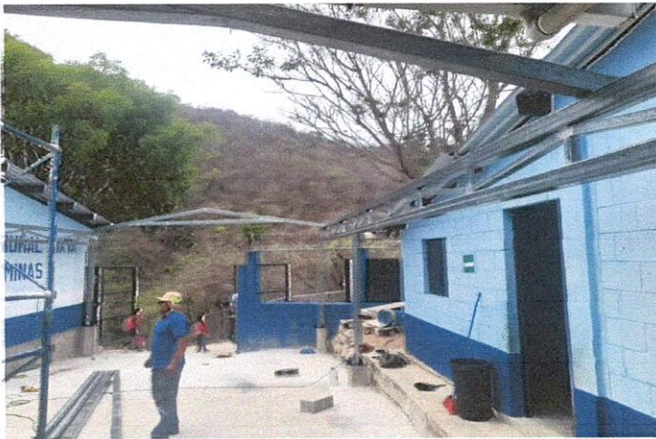
Foto 3: Mejoramiento con estructura metálica.
