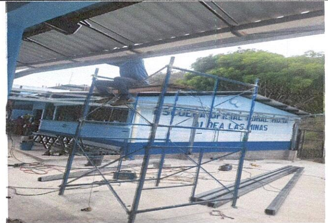
Foto 4: Mejoramiento de Estructura Metálica.
